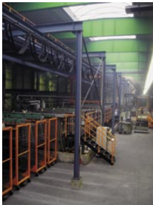
Blick auf die Gestellanlage im Werk Brehna
